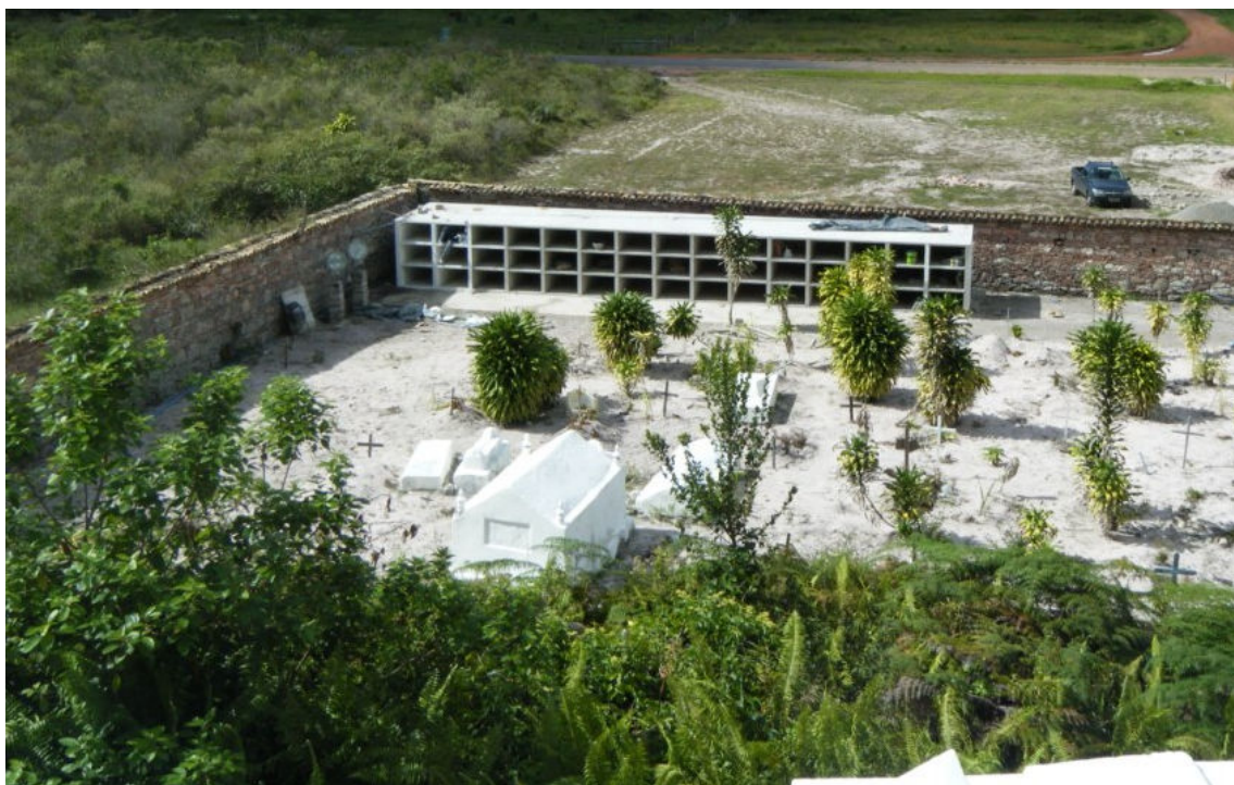
Figura 20: Jazigos construídos na reforma realizada no Cemitério Santa Isabel, 2011
