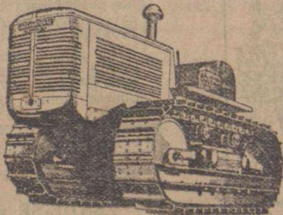
Modelo International TD-18 com motor Diesel de 6 cilindros; desenvolve 72.38 H. P. (max.) na barra de tracção e 80.32 H. P. na polia.
