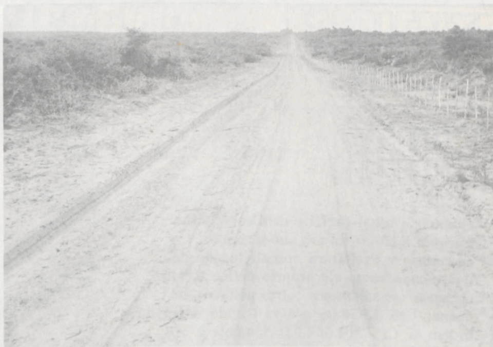
A construção, recuperação, alargamento das estradas de Ceará-Mirim tem sido uma preocupação do Administrador.
