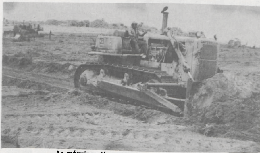
As máquinas já prepararam o terreno da CEASA
