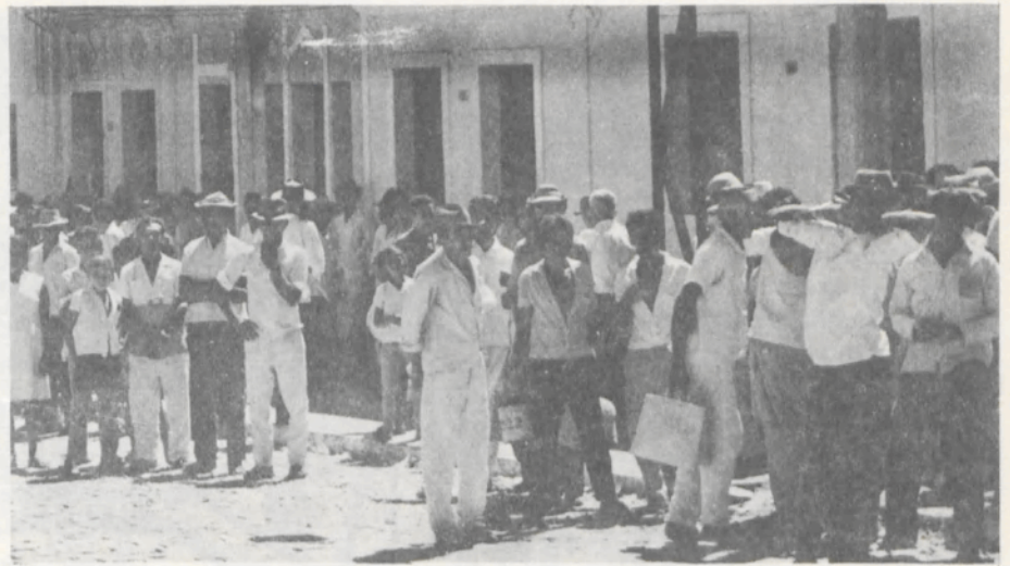
Serão evitadas as frentes de trabalho.
