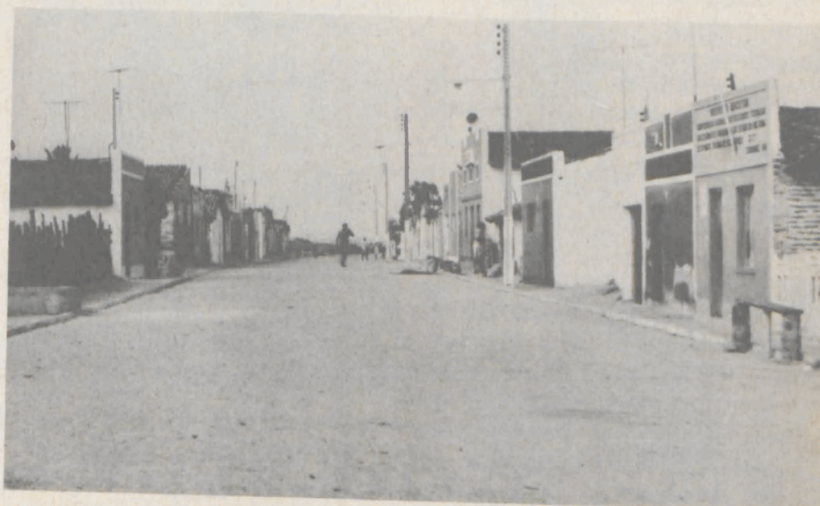
A administração promove a pavimentação da cidade.
