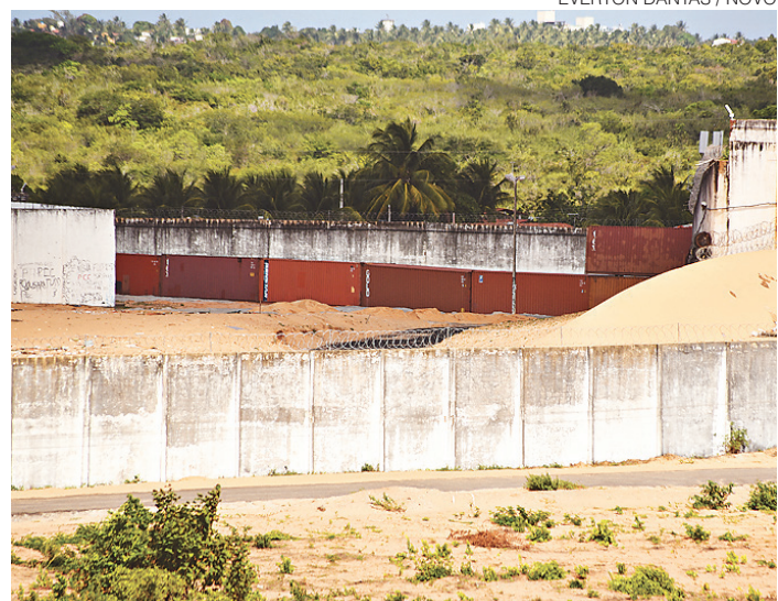
// Governo já construiu um muro de contêineres em Alcaçuz
