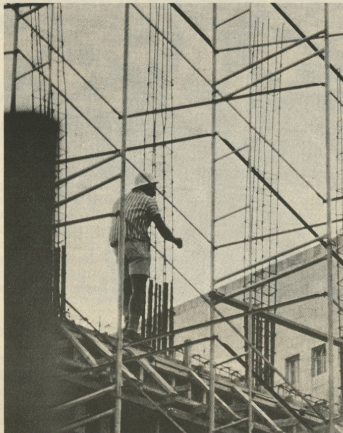
Na construção civil, peões fizeram greve em todo o Brasil.
