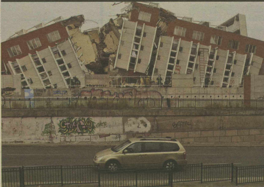
Bombeiros ainda acreditam no resgate de sobreviventes no prédio de 14 andares que desabou em Concepción
