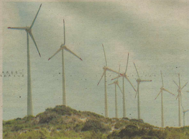
Aerogeneradores no litoral potiguar, assentados sobre área alugada
