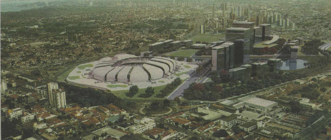
Primeiras obras são para o aterro, drenagem e construção de novo acesso do Centro Administrativo
