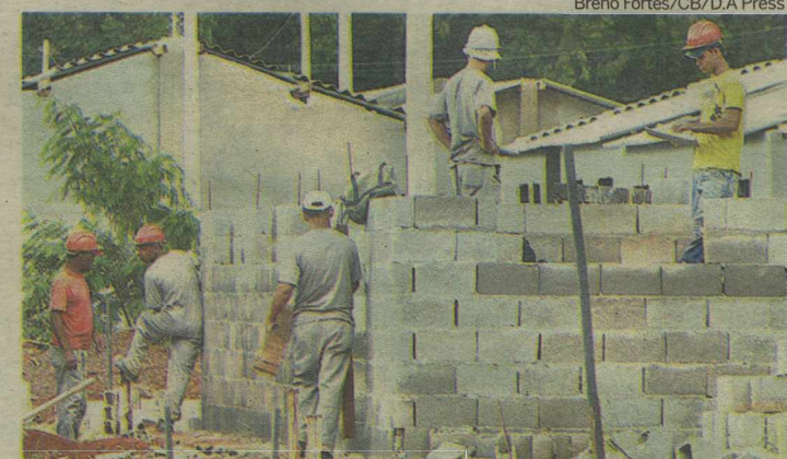
Construção civil foi o setor que mais se destacou em março
