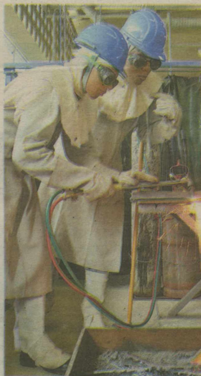
Habilitação de soldadores feita no Senai
