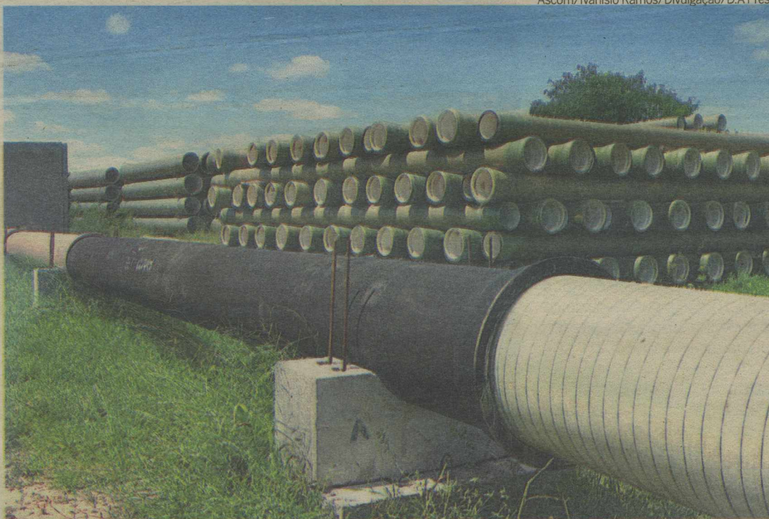
Adutora vai abastecer a segunda maior cidade do Rio Grande do Norte, que hoje depende de poços e barragem
