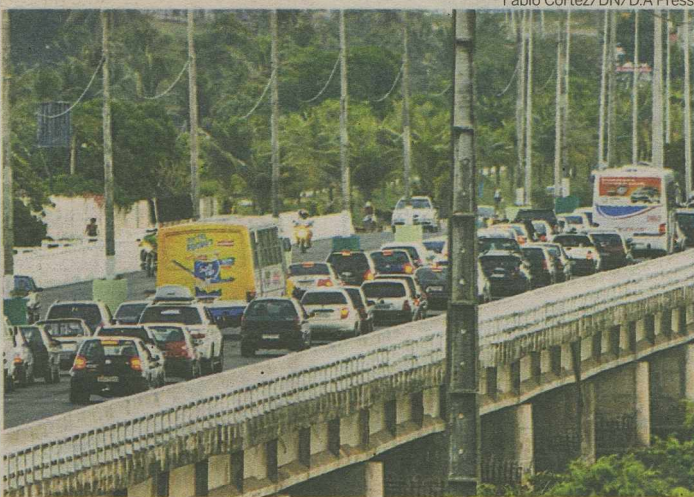
Passagem sobre o Potengi receberá obras provavelmente até início de 2011
