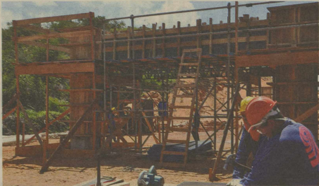
Trabalhadores atuavam ontem pela manhã nos serviços da passagem rodoviária sobre o Rio Pitimbu
