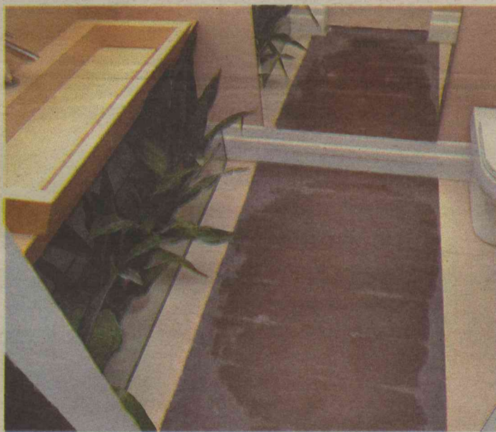
O lavabo: piso é aplicado sobre o anterior, que não precisa ser quebrado
