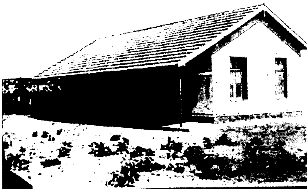
Um dos grupos recém-construídos do Leprosário
