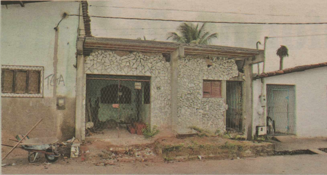
Tragédia aconteceu depois que morador subiu em construção na Rua Nova Descoberta, Zona Oeste de Natal
