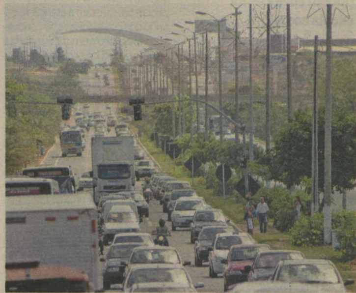
Um forte movimento é esperado nas rodovias federais nos próximos três dias
