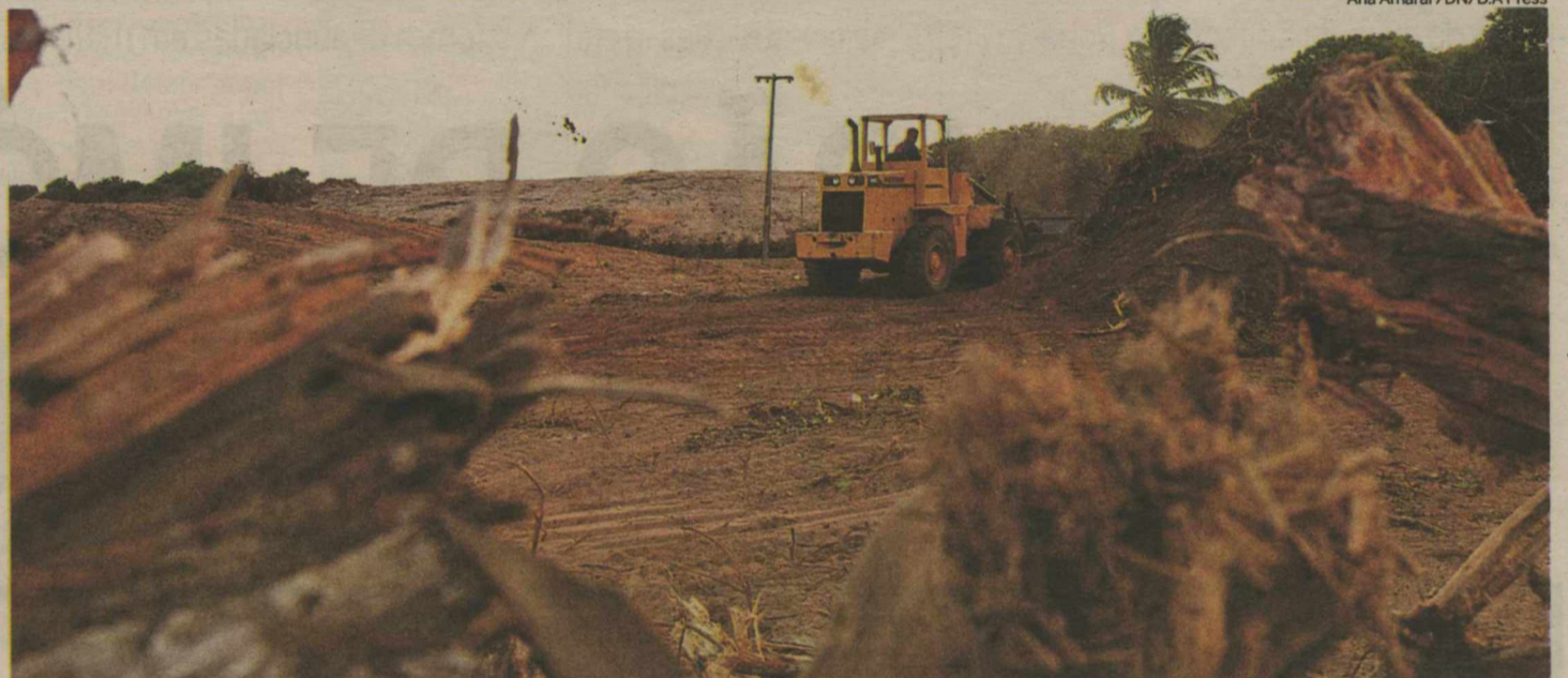
Máquinas abrem caminho para o novo trecho, que ficará entre a Avenida dos Xavantes, na Cidade Satélite, e a Avenida Rio Jordão, em Parnamirim
