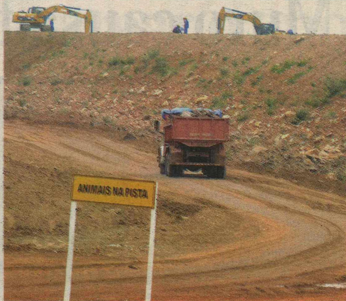
Veículo utilizado nas obras de transposição do Rio São Francisco
