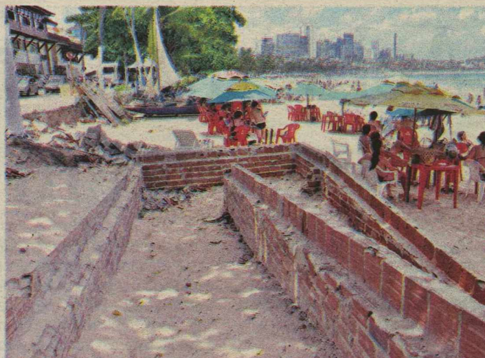
Única rampa de acessibilidade da praia ainda não foi concluída
