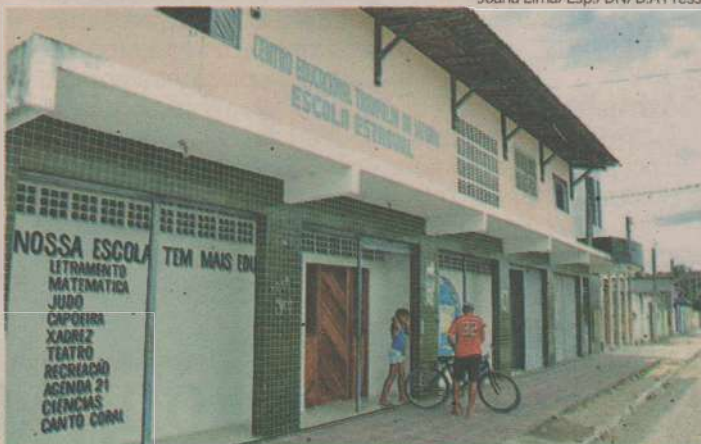
A estrutura atual não teria condições de abrigar a unidade de ensino
