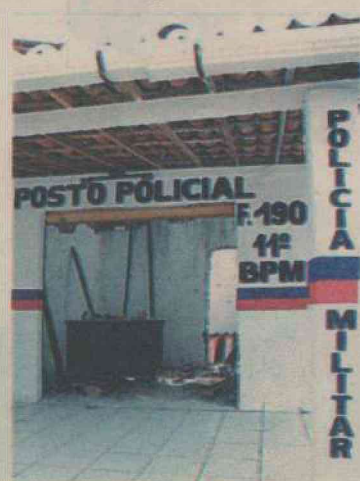
Posto policial está em reforma
