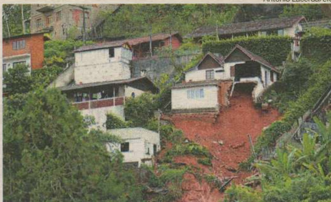
Casa destruída após deslizamento de terra em Teresópolis
