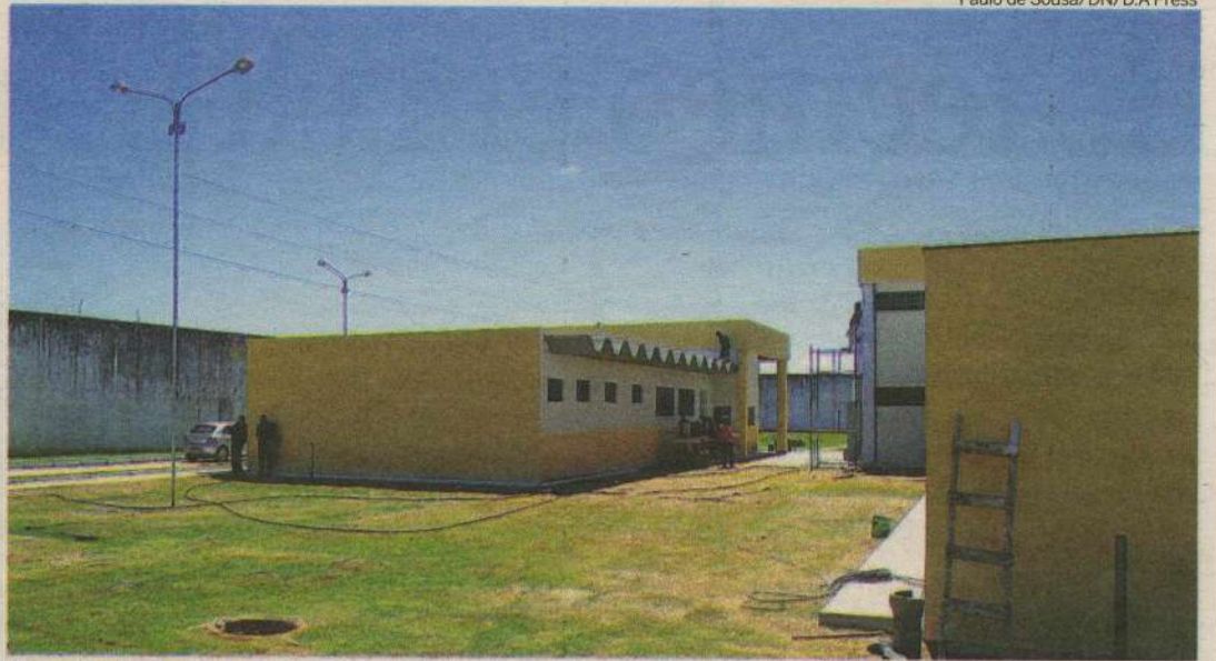
A nova estrutura terá segurança reforçada, com 52 celas e capacidade para abrigar 402 presos
