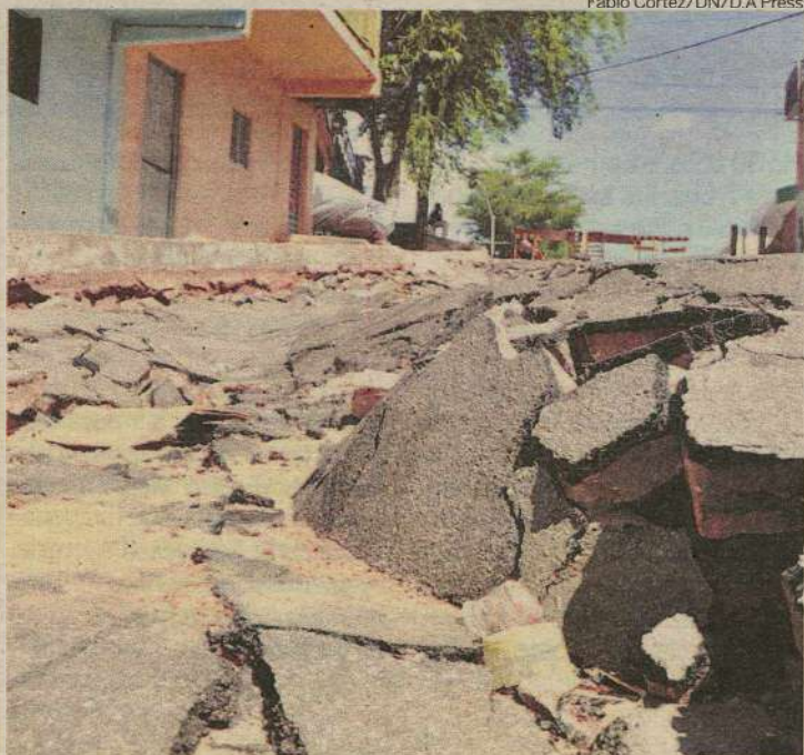
Intensas chuvas e canos estourados seriam a causa do problema na avenida
