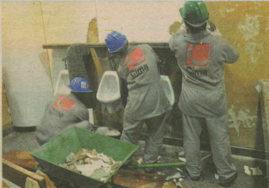
Recuperação dos banheiros estão entre as intervenções iniciais da reforma
