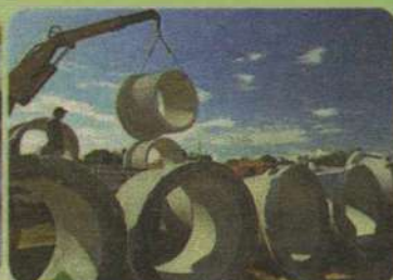
Mais de 300 ruas drenadas e saneadas
