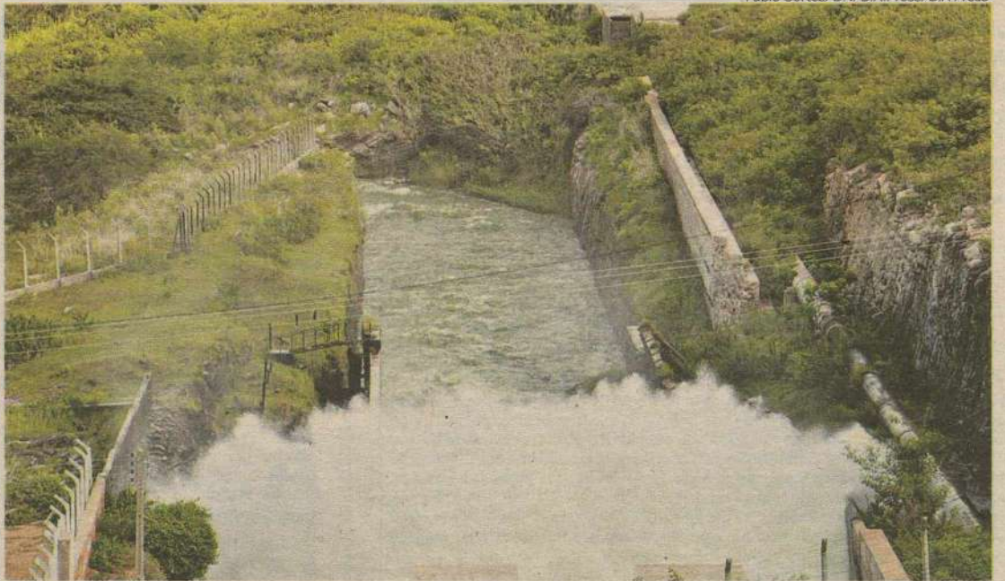
Faltando apenas 4,5 metros para sangria da maior barragem do RN, Defesa Civil teme possíveis inundações
