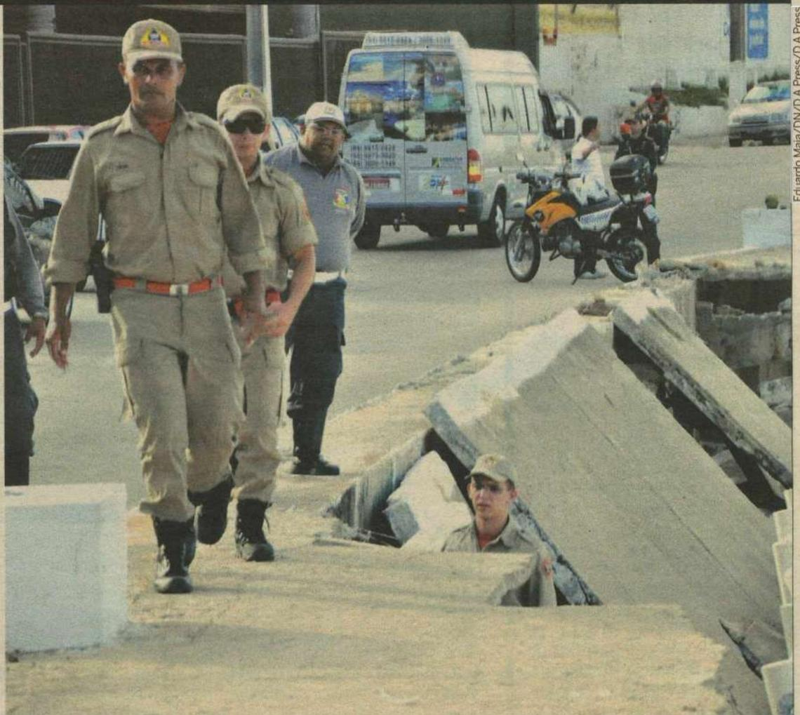
Bombeiros isolaram o local. Falta de manutenção da estrutura metálica e avanço do mar podem ter ocasionado queda
