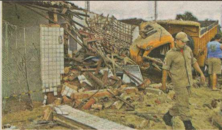
Parte do prédio em que ficavam as crianças não chegou a ser atingida
