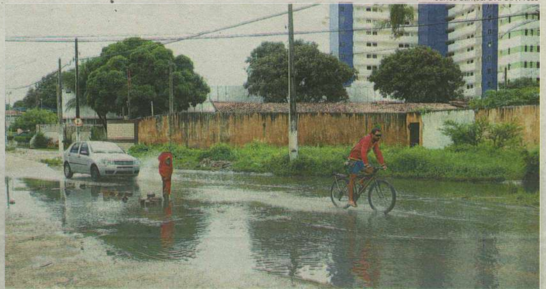
Água esconde buraco profundo na Avenida Ayrton Senna, causando acidentes com motociclistas
