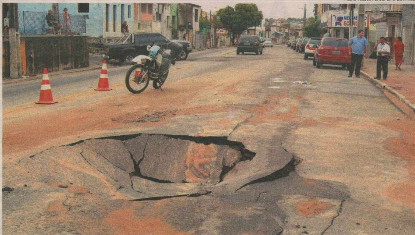
BURACOS // O estouro de uma tubulação da Caern abriu uma cratera de quase dois metros de diâmetro nas Quintas. PÁGINA 2
