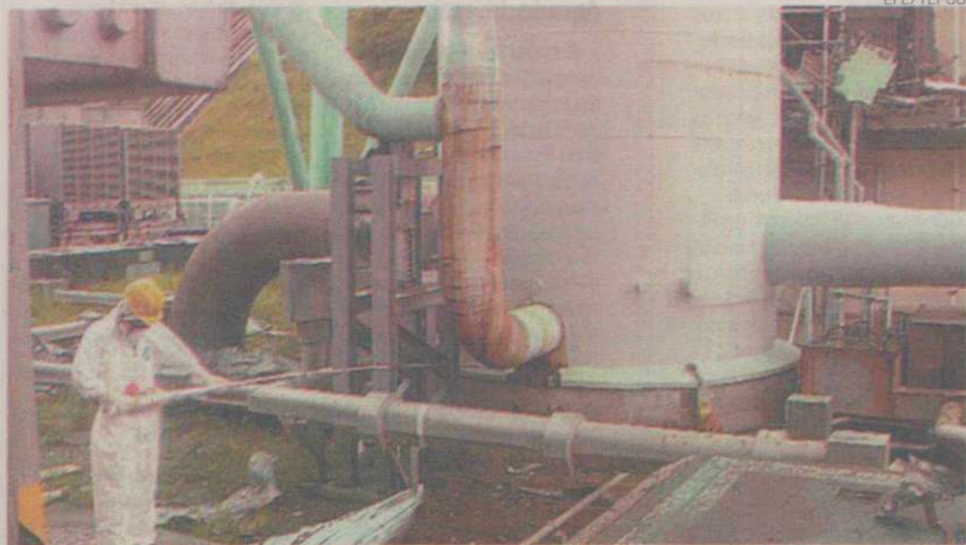
Leituras aconteceram na área externa que fica entre os edifícios dos reatores 1 e 2, além do segundo andar da construção
