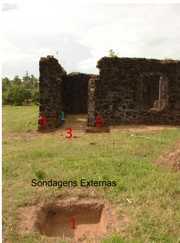
Fotografia 25 – Sondagens de 01 a 04, no espaço externo à edificação. (Medeiros, 2008)
