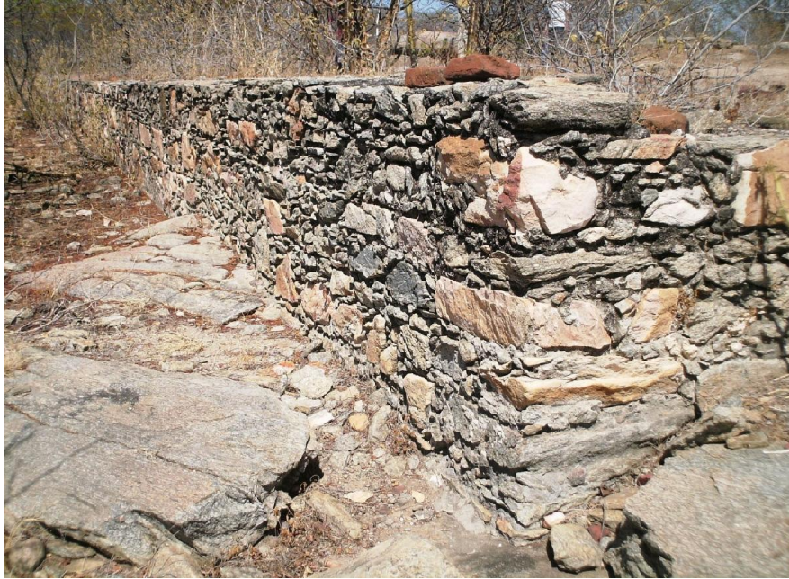
Fotografia 74 – Vista frontal das estruturas de alicerces sobre o lajedo, com o detalhe do vértice da estrutura denominada de Setor A, no sentido oeste-leste. (Silva, 2008)
