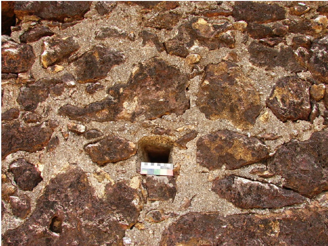
Fotografia 24 – Detalhe de uma das paredes com orificios quadrangulares que vazam as paredes e que aparecem na estrutura. (Silva, 2008)
