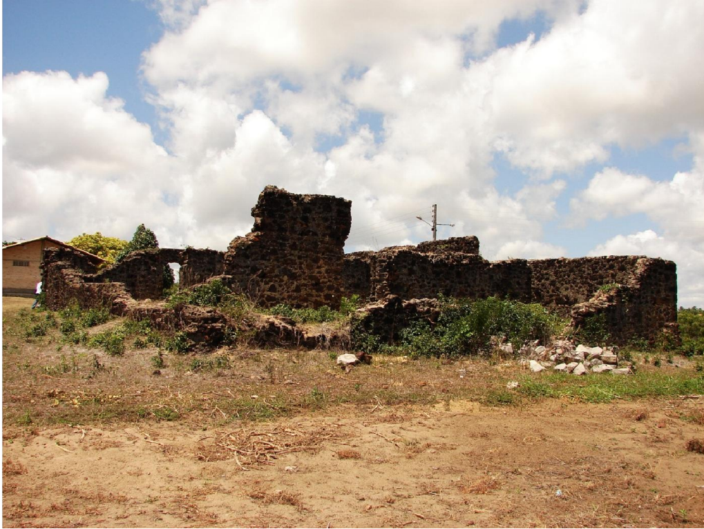
Fotografia 19 - Vista frontal do sítio Casa de pedra do Pium, desde o que se considerou sua parte posterior, mostrando o processo de desmoronamento e retirada de partes das seções de paredes. (Silva, 2008)
