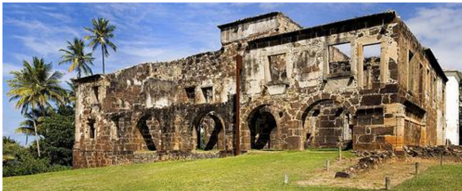
Fig. 24 – Ruínas da Casa (Castelo) da Torre de Garcia D’Ávila, em Tatuapara – Camaçari-BA, edificada em 1551, que por ordem de D. João III mandou construir a então Torre Singela de São Pedro de Rates. 115
