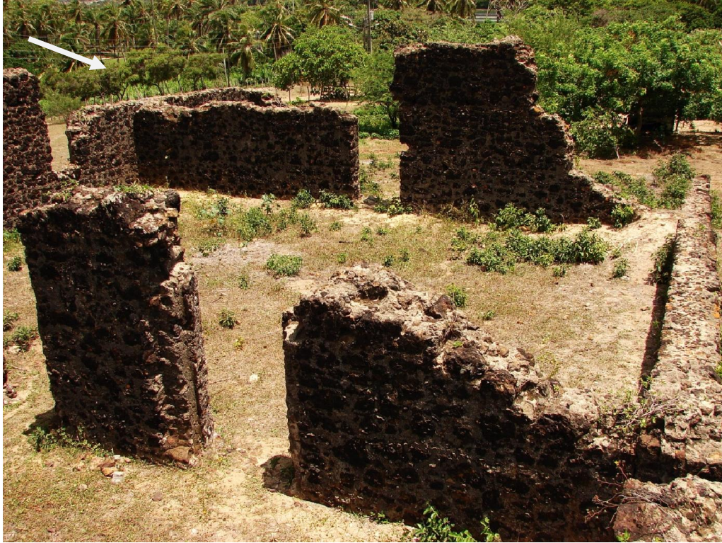
Fotografia 21 – Vista panorâmica da disposição das paredes internas vê-se os detalhes no sentido sul-norte, e ao fundo a vegetação que segue o curso do riacho Pium. (Silva, 2008)
