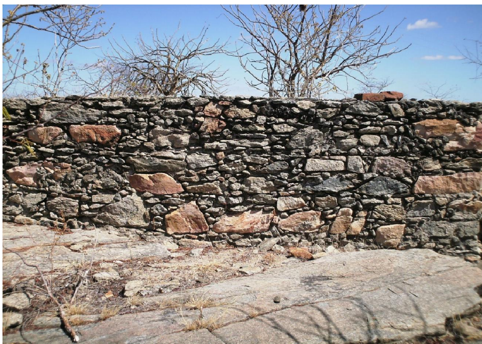
Fotografia 73 - Vista lateral da estrutura de pedras e argamassa de cimento que está montada sobre o lajedo, observada pelo caminho que dá acesso ao sítio e que foi identificada erroneamente na historiografia como sendo as ruínas da casa forte do Cuó. (Silva, 2008)
