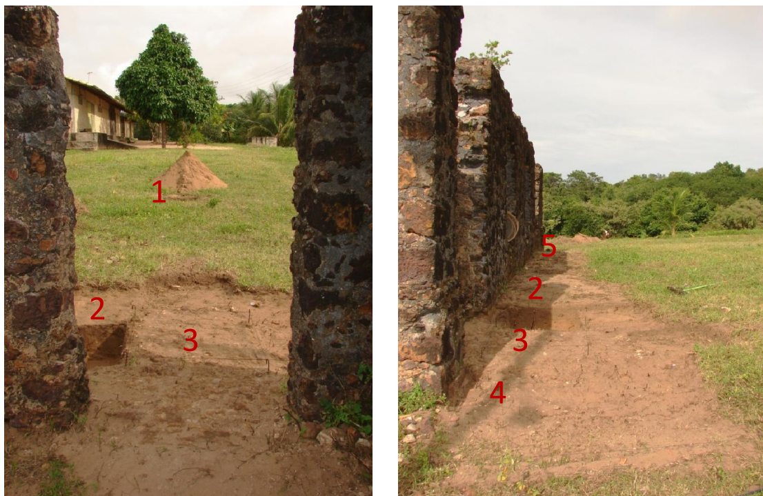
Fotografias 25 e 26 - Sondagens (1 a 5) externas à edificação. (Medeiros, 2008)
