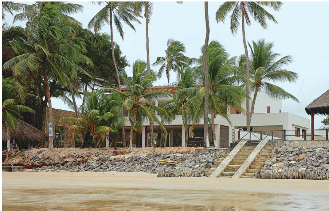
Casa de praia sendo construída em Porto Mirim
