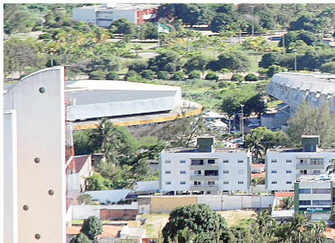
► Machadão será demolido para dar lugar ao Estádio das Dunas
