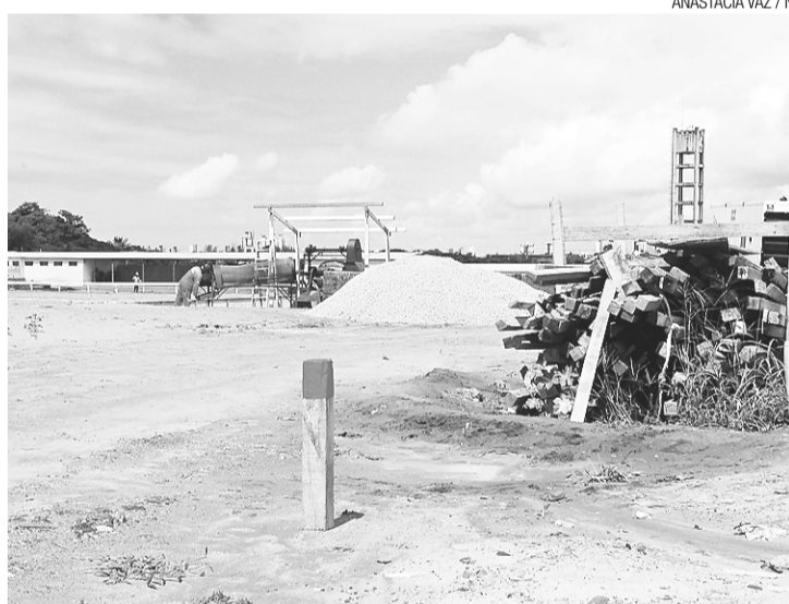
► Canteiros de obras da sede do MetrÓpole Digital
