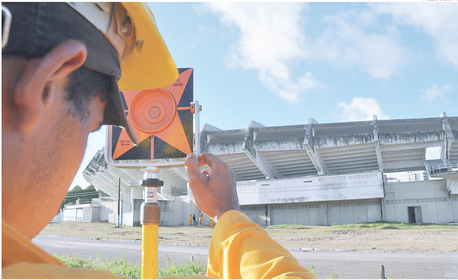
► Técnico utiliza equipamento para fazer levantamento topográfico em frente ao Machadão
