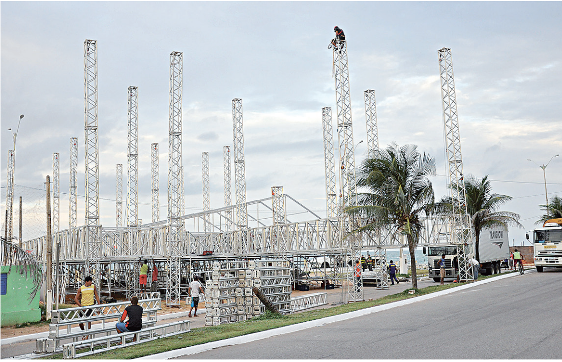
▶ Montagem do palco na Praia do Meio
