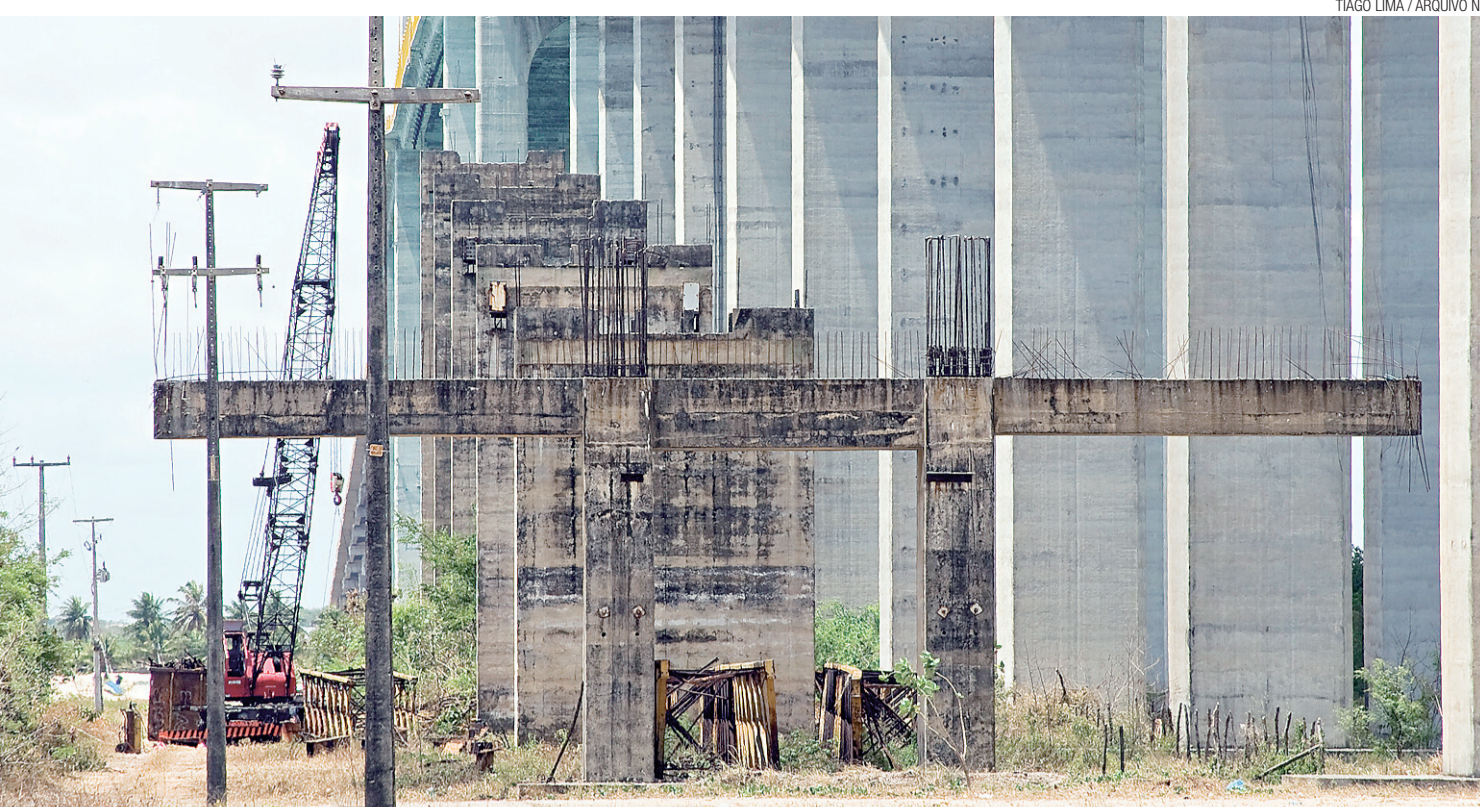
▶ Pilares do que seria uma ponte sobre o rio Potengi só poderão ser demolidos ao fim da pendenga judicial
