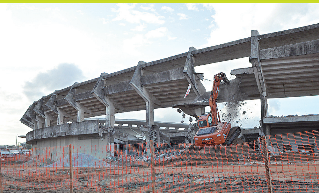
▶ Rompedor hidráulico detona parte da arquibancada
