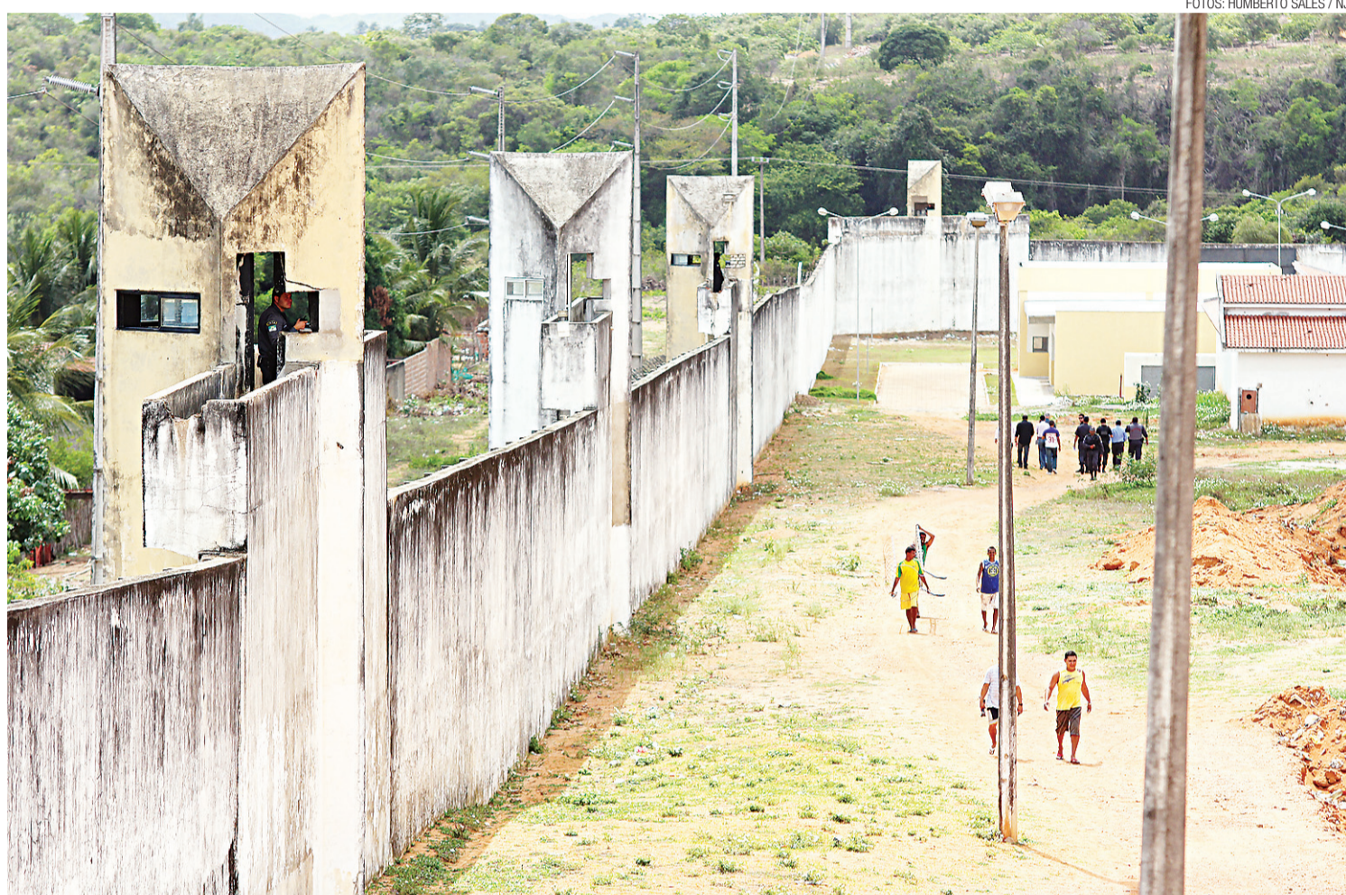
▶ Alcaçuz recebe a visita do engenheiro Marcos Glimm, da empresa gaúcha Verdi Construções, responsável pelo projeto e execução das obras do novo pavilhão
