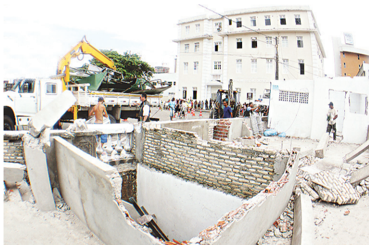
► Demolição continua amanhã
