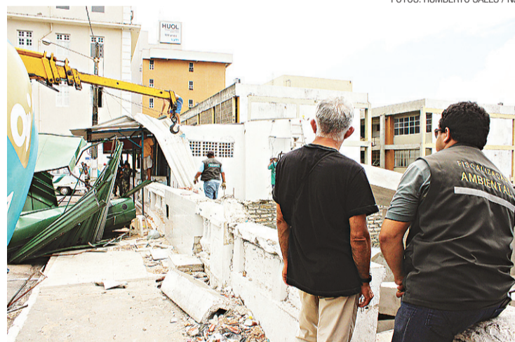
► Doze homens da Semsur e da Semurb executam serviço
