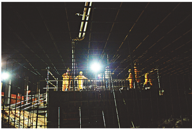
► Operários trabalham em três turnos no canteiro da Arena das Dunas
