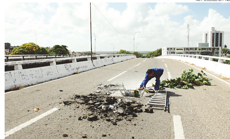
► Com máquinas e picaretas, os homens abrem "janelas" no viaduto
