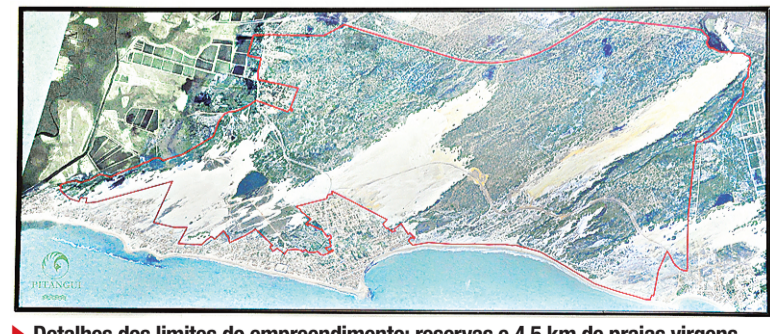
▶ Detalhes dos limites do empreendimento: reservas e 4,5 km de praias virgens
