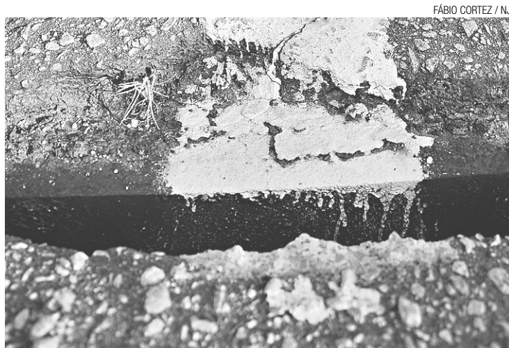
► Rachadura na cabeceira do Viaduto do Baldo já tem 14 cm e estrutura vai precisar receber o reforço urgente de uma escora
