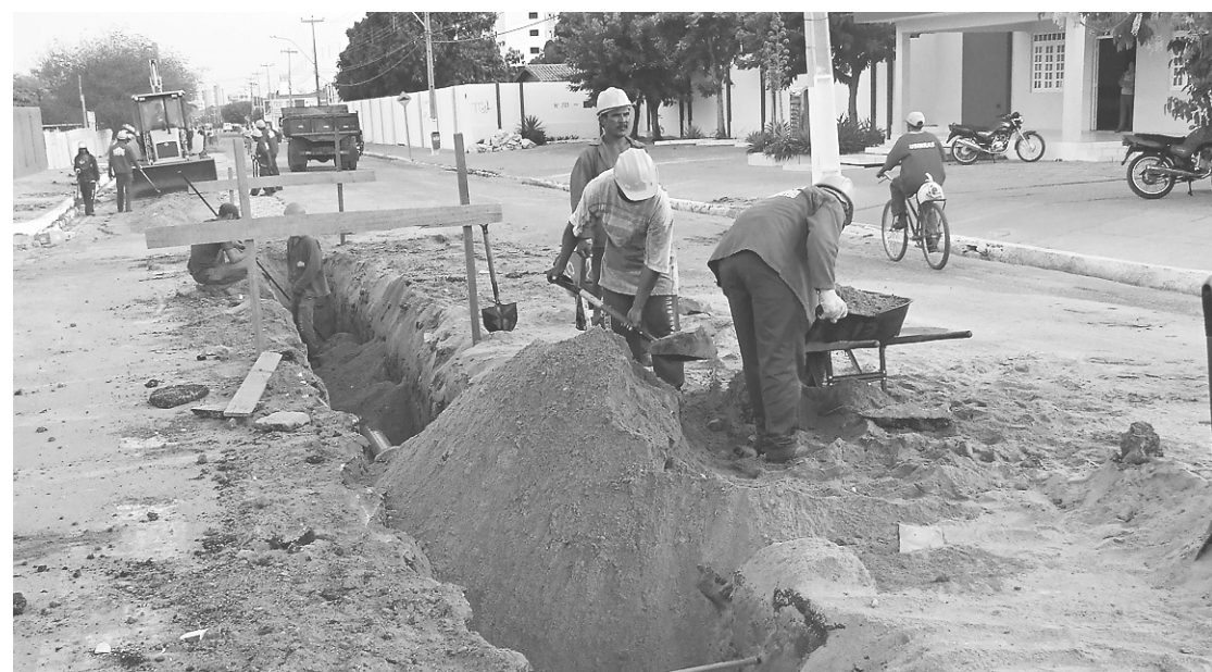
▶ Operários trabalhando em Pamamirim: capilarização de obras
