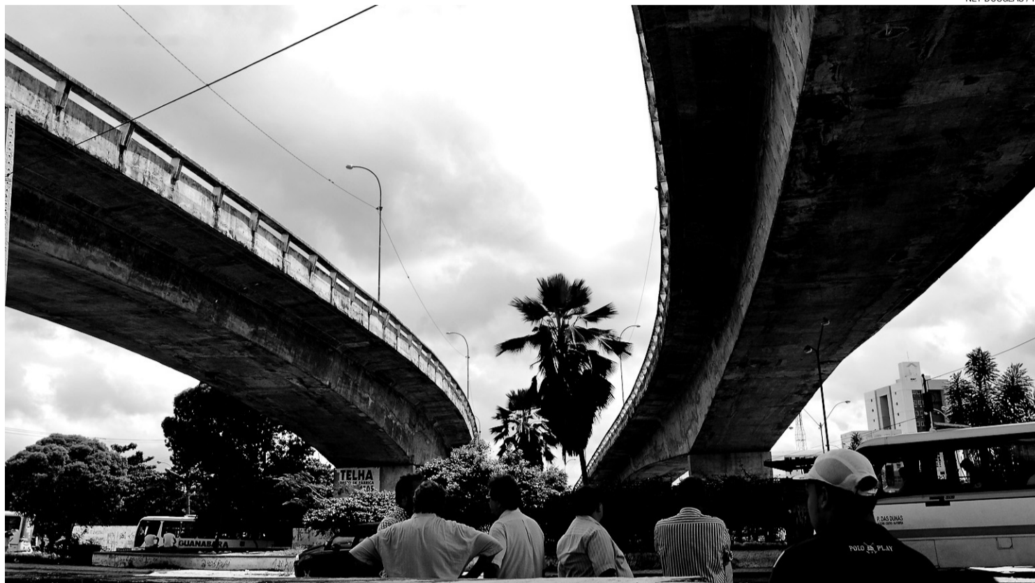
► Uma semana depois da assinatura da ordem de serviço para recuperação do canal de drenagem e do viaduto do Baldo, obra continua sem previsão de começar
