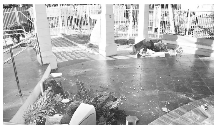
Jarros que ornamentam a entrada da Casa também foram destruídos
